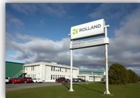
Centre de transformation St-Jérôme (Qc) Canada
