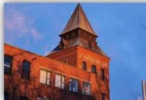
Usine de fabrication St-Jérôme (Qc)Canada
